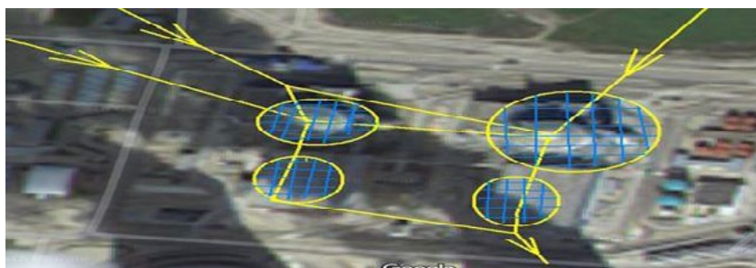
Figure 7: Centrale Nucléaire De Nogent, France
